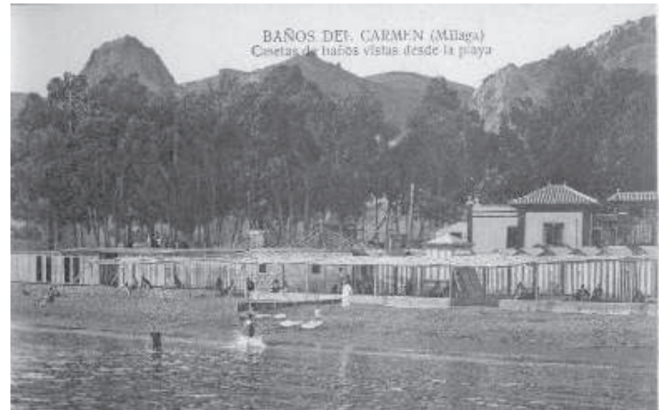
Baños del Carmen (Málaga) Casetas de baños vistas desde la playa. Postal.
